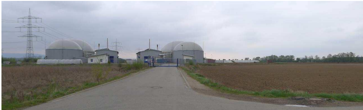
Abb. 2 Blick auf das Untersuchungsgebiet von der Zufahrtsstraße zur Biogasanlage
